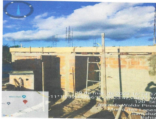
Foto 50- EXECUÇÃO DAS VIGAS
