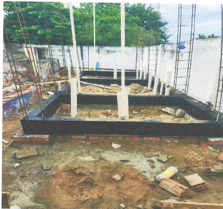
Foto 41- IMPERMEABILIZAÇÃO DO BALDRAME
