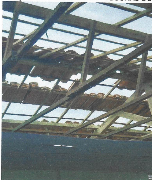
Foto 11- REMOÇÃO DO FORRO E DAS TESOURAS DO TELHADO.
