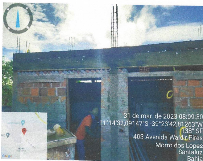
Foto 60- DESFORMA DA CONCRETAGEM DA LAJE E CHAPISCO
