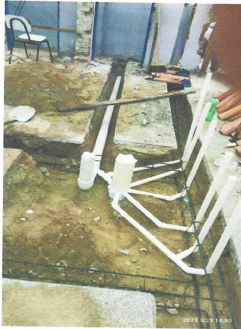
Foto 39- EXECUÇÃO DO ESGOTO DOS SANITÁRIOS
