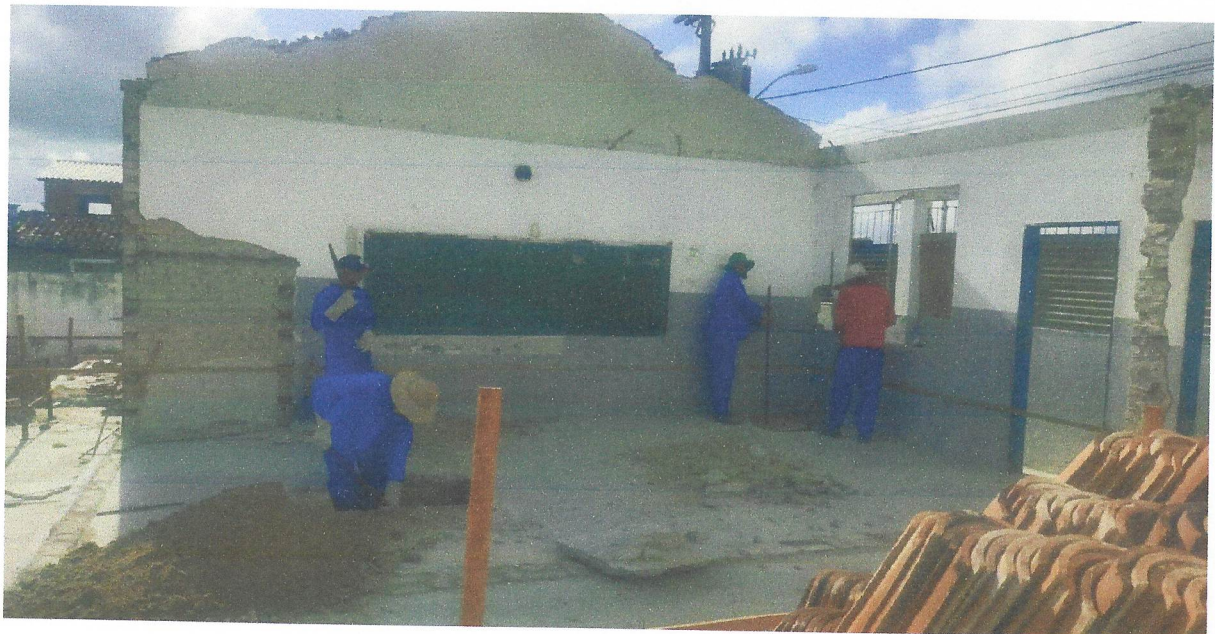
Foto 24- ESCAVAÇÃO DAS SAPATAS
