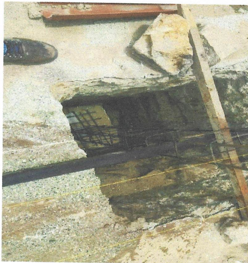
Foto 26- EXECUÇÃO DAS SAPATAS
