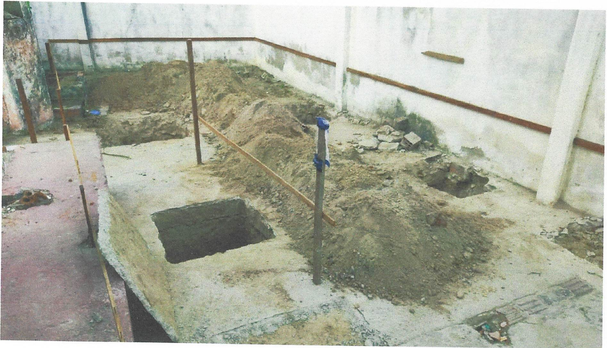
Foto 25- ESCAVAÇÃO DAS SAPATAS
