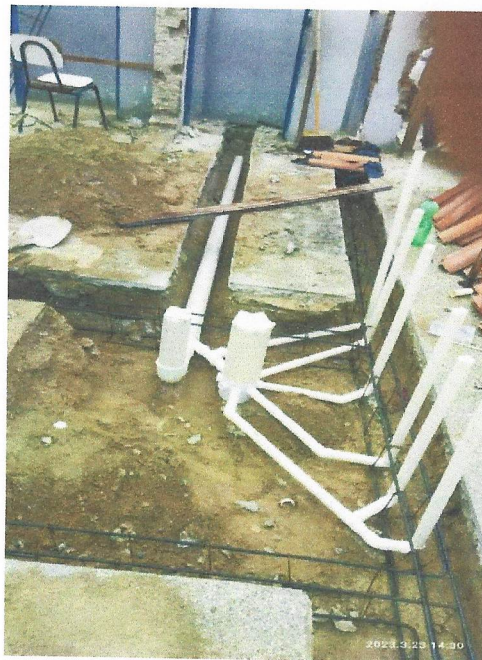
Foto 39- EXECUÇÃO DO ESGOTO DOS SANITÁRIOS
