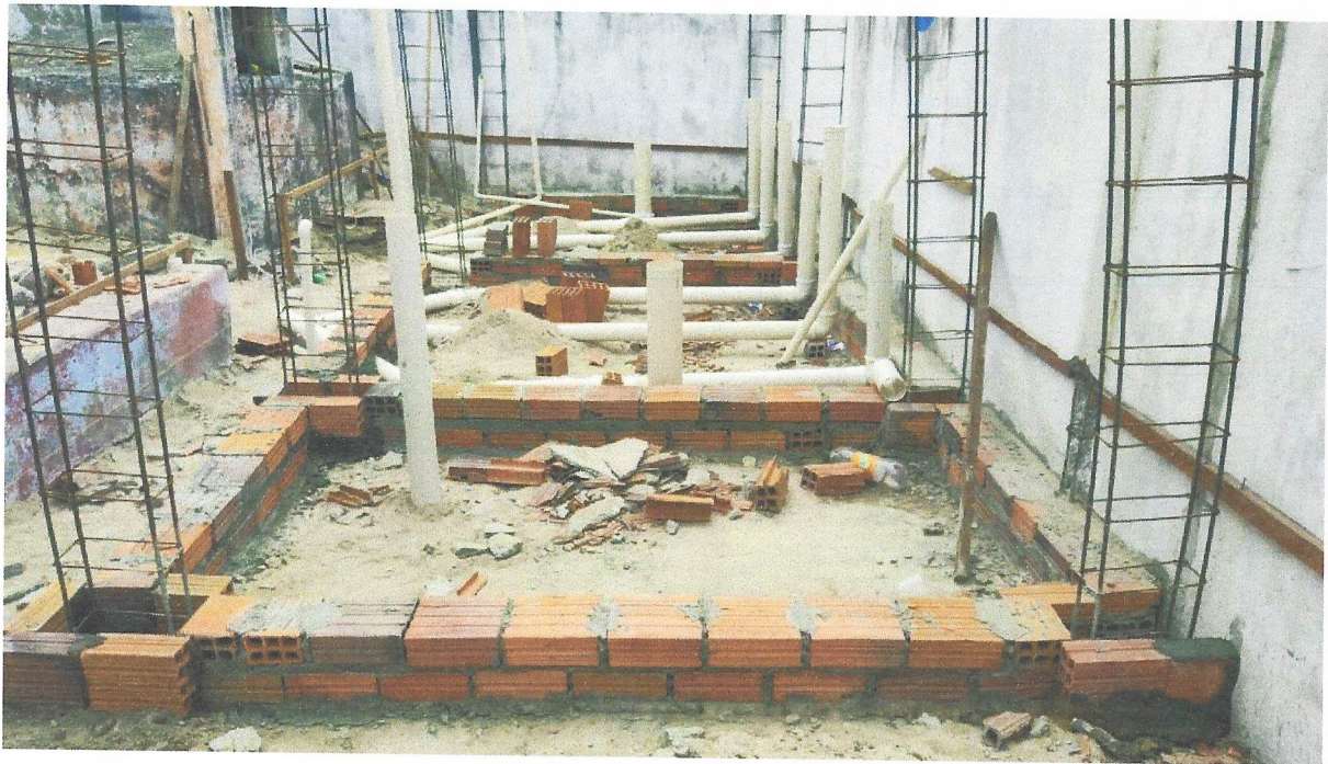
Foto 37- EXECUÇÃO DO ESGOTO DOS SANITÁRIOS
