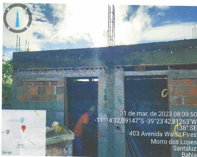
Foto 59- DESFORMA DA CONCRETAGEM DA LAJE E CHAPISCO
