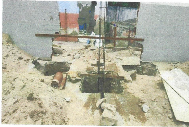
Foto 29- CONCRETAGEM DAS SAPATAS
