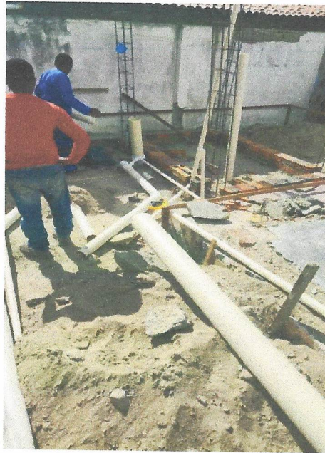
Foto 36- EXECUÇÃO DO ESGOTO DOS SANITÁRIOS
