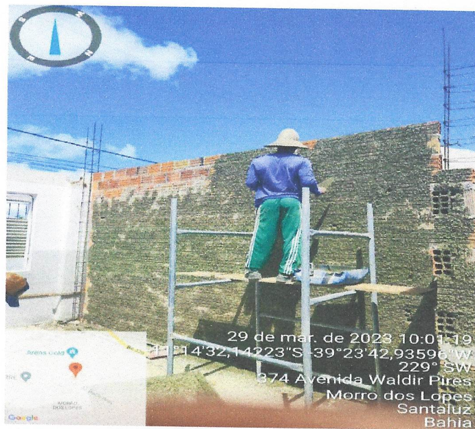
Foto 49- CHAPISCO DAS PAREDES
