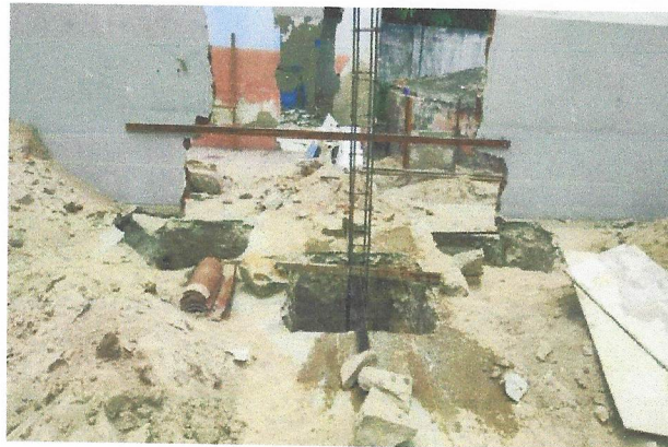
Foto 30- CONCRETAGEM DAS SAPATAS
