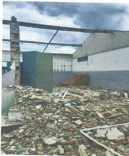
Foto 10- REMOÇÃO DAS TERÇAS E TESOURAS DO TELHADO E DEMOLIÇÃO DAS PAREDES
