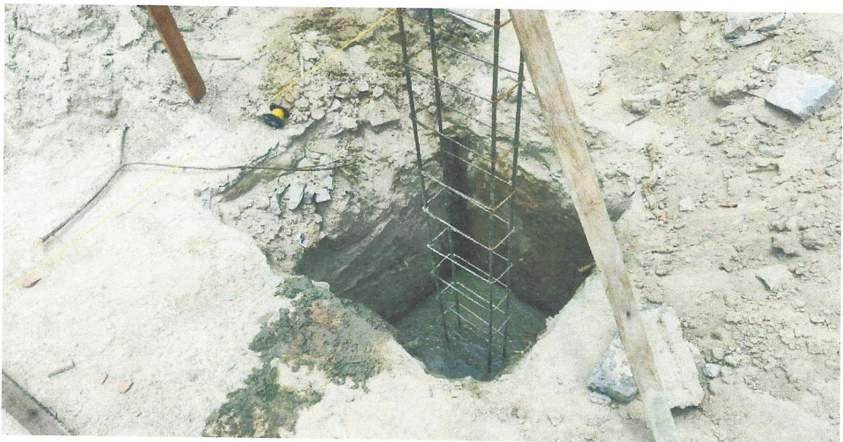
Foto 28- CONCRETAGEM DAS SAPATAS
