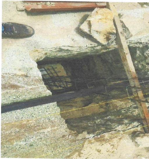
Foto 26- EXECUÇÃO DAS SAPATAS
