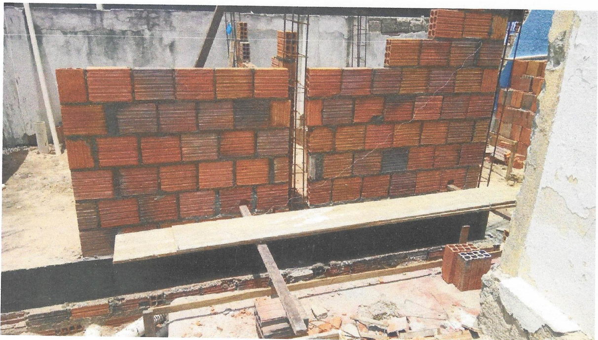
Foto 44- LEVANTE DE ALVENARIA
