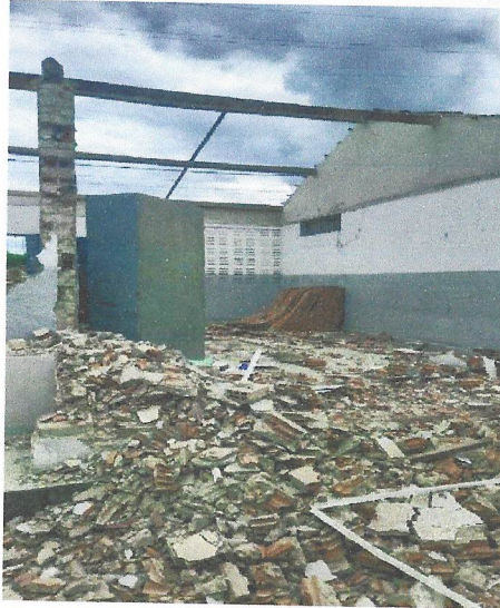
Foto 09- REMOÇÃO DAS TERÇAS E TESOURAS DO TELHADO E DEMOLIÇÃO DAS PAREDES
