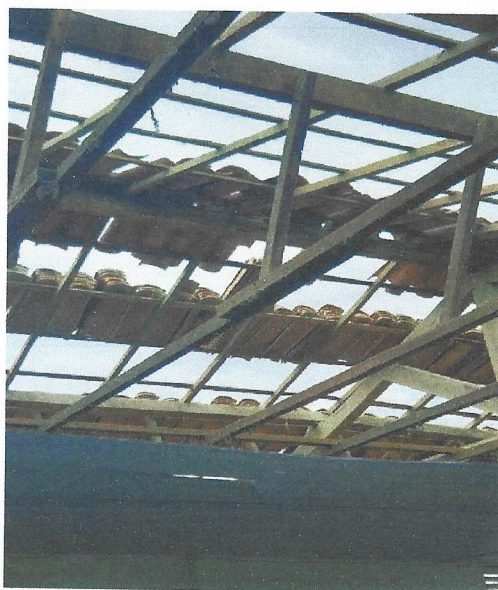
Foto 12- REMOÇÃO DO FORRO E DAS TESOURAS DO TELHADO.
