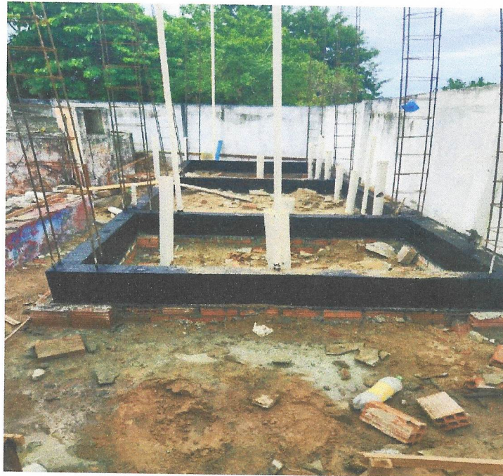
Foto 41- IMPERMEABILIZAÇÃO DO BALDRAME
