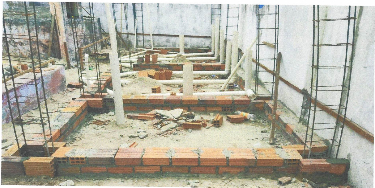
Foto 37- EXECUÇÃO DO ESGOTO DOS SANITÁRIOS
