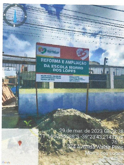
Foto 02 – PLACA DA OBRA
