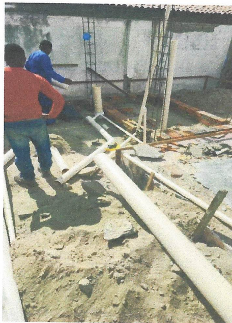
Foto 36- EXECUÇÃO DO ESGOTO DOS SANITÁRIOS
