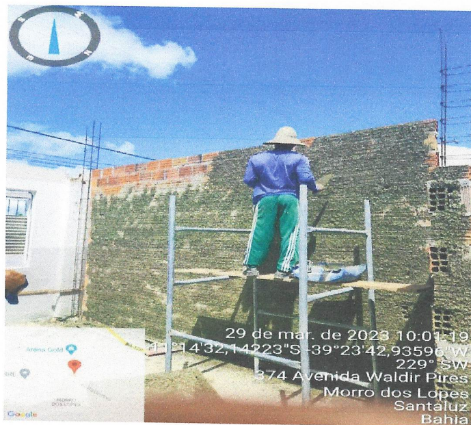
Foto 49- CHAPISCO DAS PAREDES
