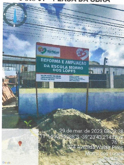
Foto 01 – PLACA DA OBRA
