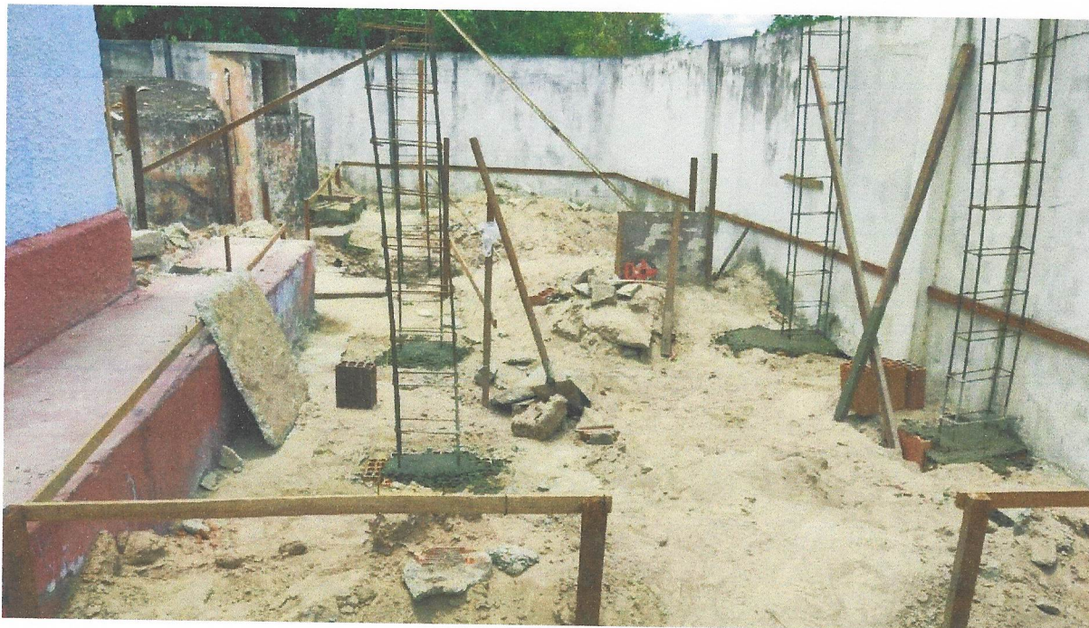
Foto 32- CONCRETAGEM DAS SAPATAS
