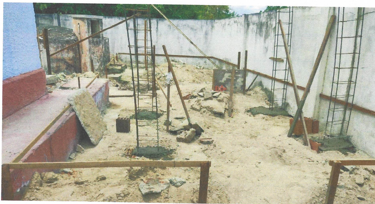
Foto 32- CONCRETAGEM DAS SAPATAS
