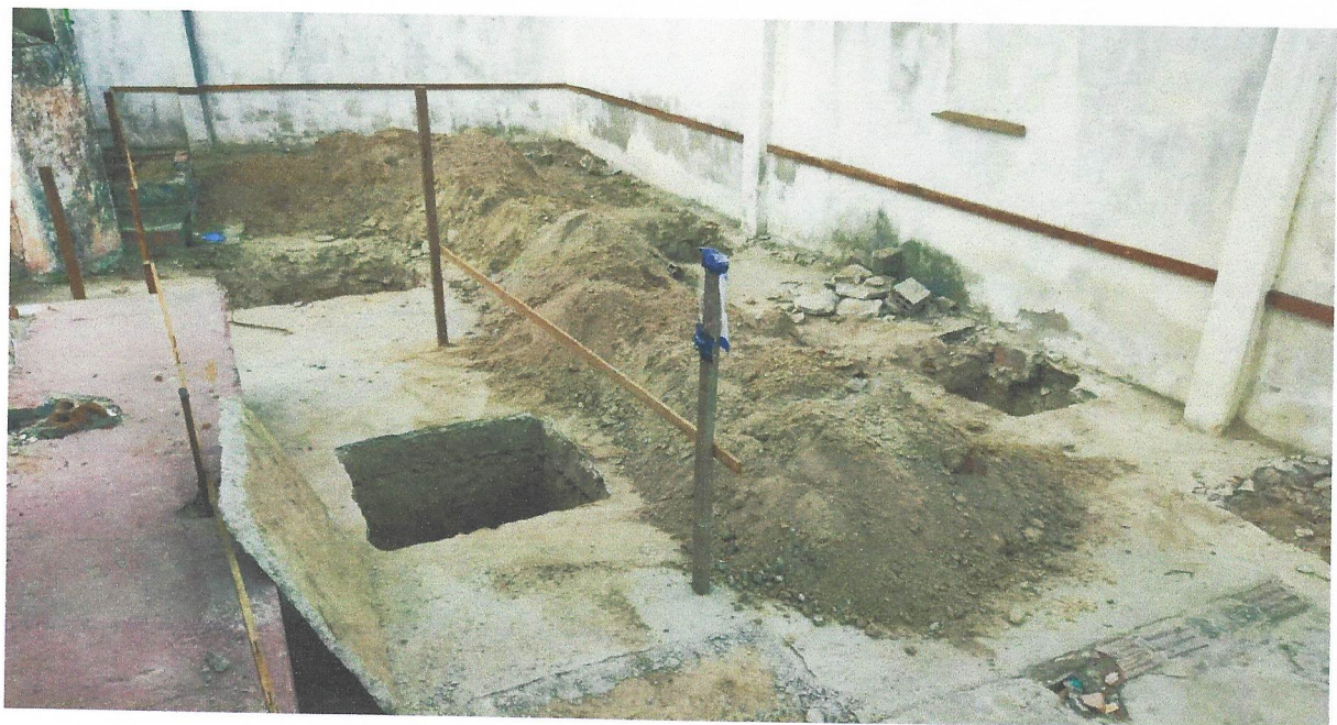
Foto 25- ESCAVAÇÃO DAS SAPATAS
