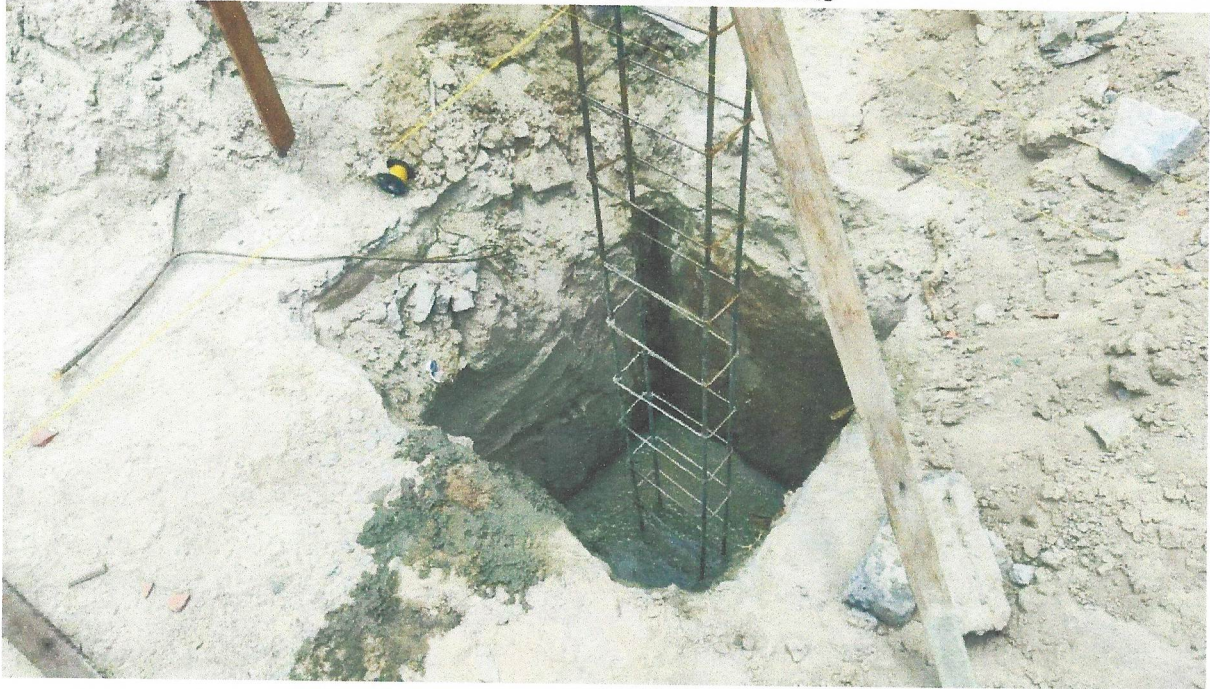
Foto 27- CONCRETAGEM DAS SAPATAS
