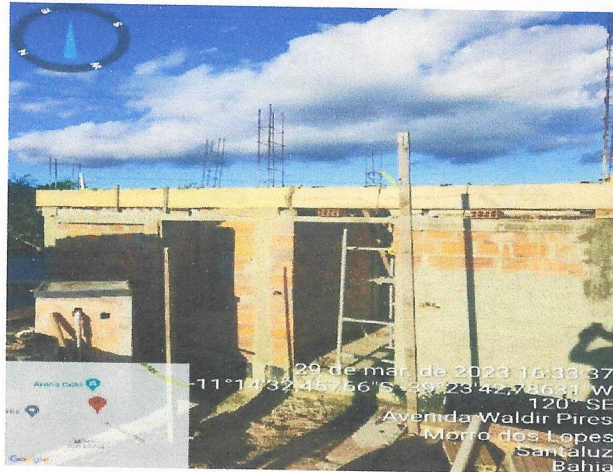
Foto 50- EXECUÇÃO DAS VIGAS
