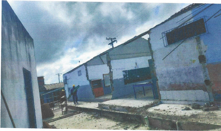
Foto 14- RETIRADA DO ENTULHO DA DEMOLIÇÃO.
