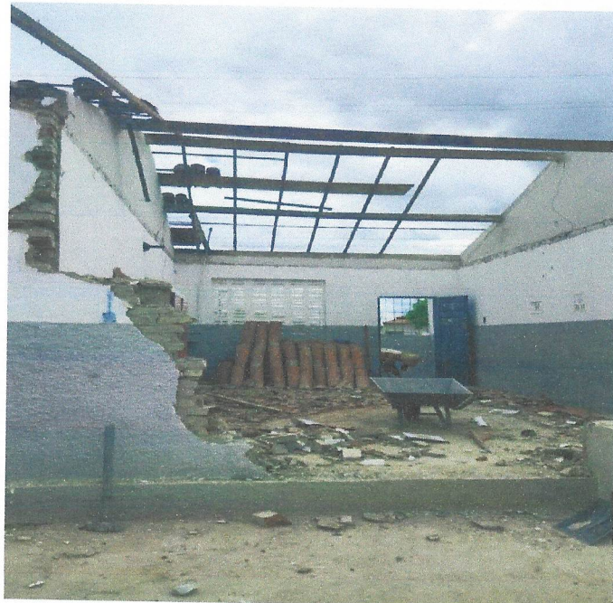
Foto 8: DEMOLIÇÃO DAS PAREDES
